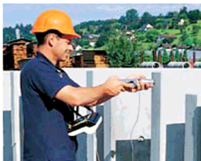
Serije testova na neugrađenim betonskim elementima sa automatskim snimanjem podataka
